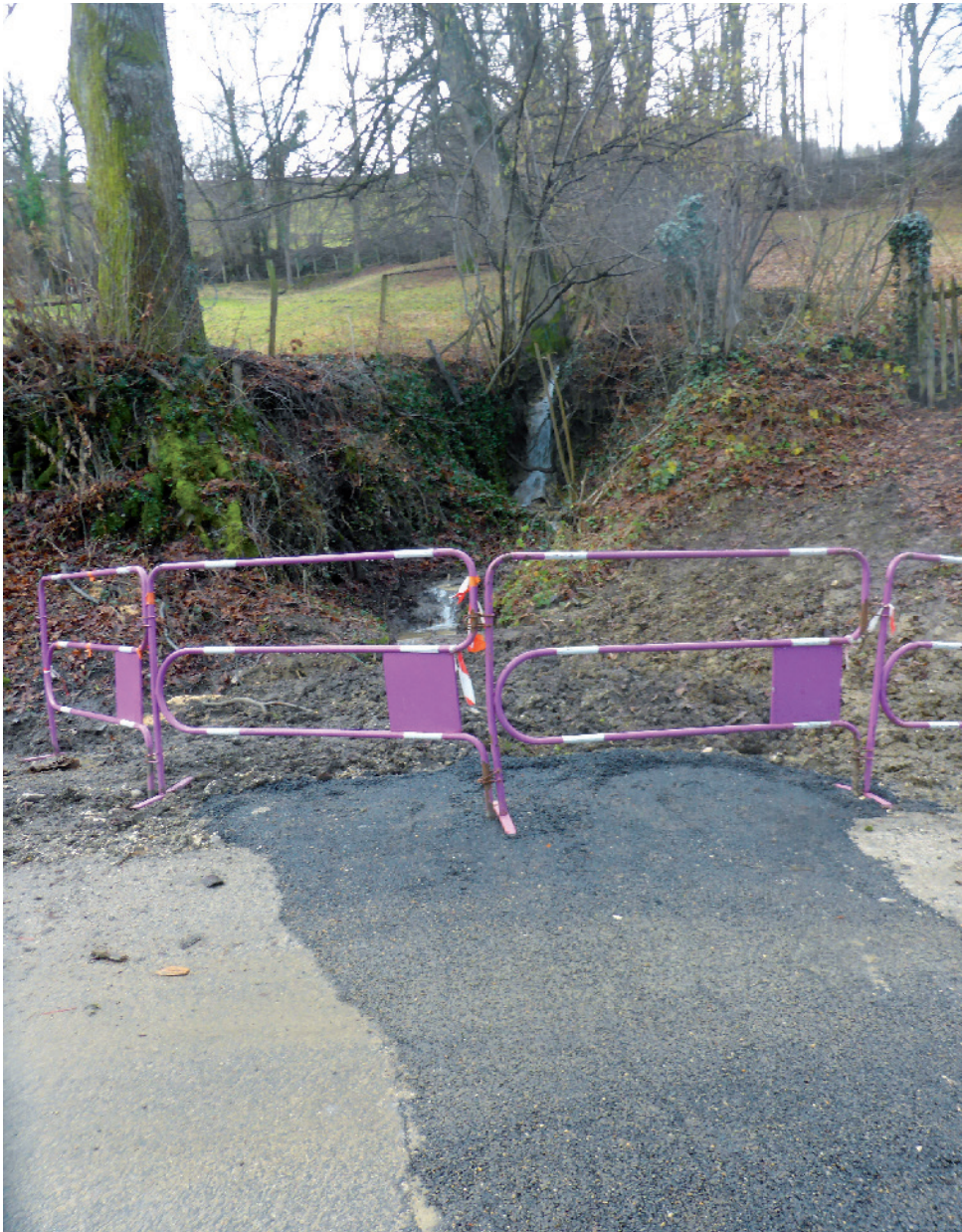
Après la coupure de la route de Murianette par un petit ruisseau... qui peut faire de gros dégâts.
