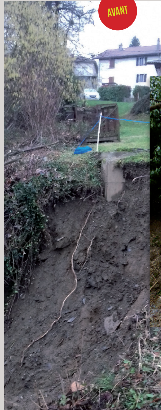
Glissement de terrain à la Faurie avec gros risque pour l'assainissement. La Métro a consolidé le talus par enrochement.
